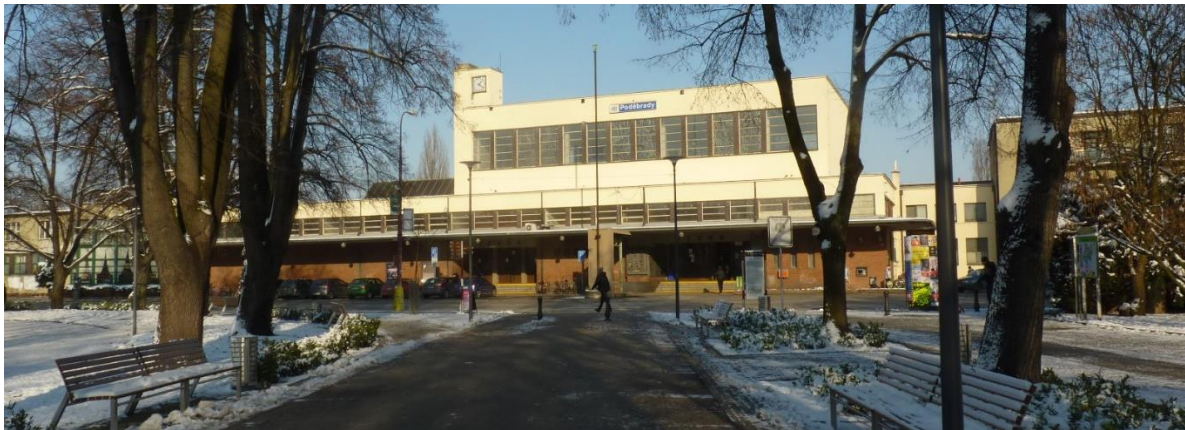
výpravní budova žst. Poděbrady z pohledu z lázeňského parku
