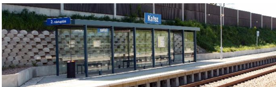
přístřešek proti povětrnostním vlivům (zast. Kažez)
