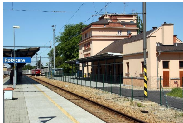
výpravní budova ze strany kolejíště a nástupiště (žst. Rokycany)
