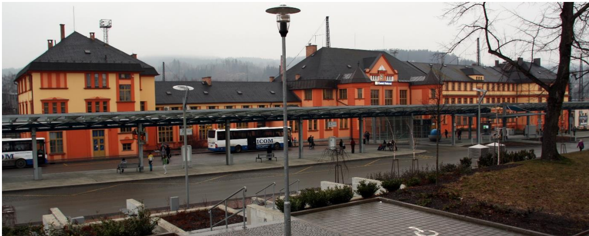
terminál VHD přímo před výpravní budovou (žst. Česká Třebová)
